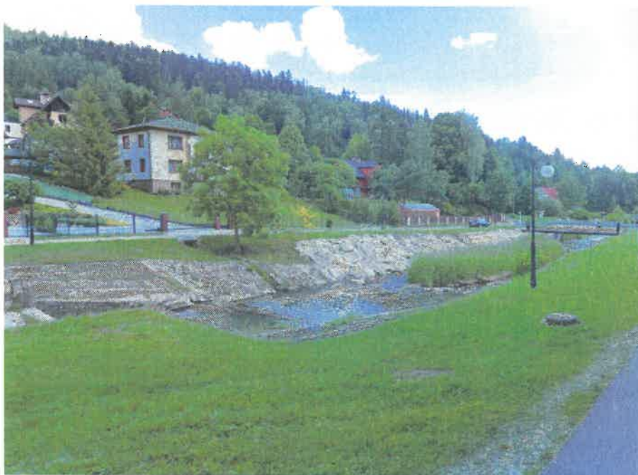
Zdjęcie 1 Okolice ulicy Wierzbowej oraz Akacjowej, miejsce w którym występuje zagrożenie dla bezpieczeństwa osób wykorzystujących obszar wodny do pływania
